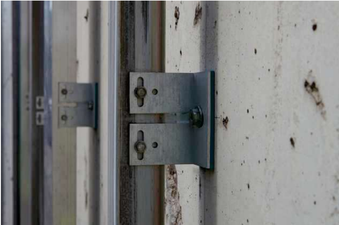
Figura 2.1.21 – Fixação dos perfis de alumínio aos esquadros de suporte
