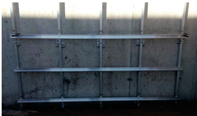
Figura 2.2.16 – Vista do perfil rail disposto na horizontal
