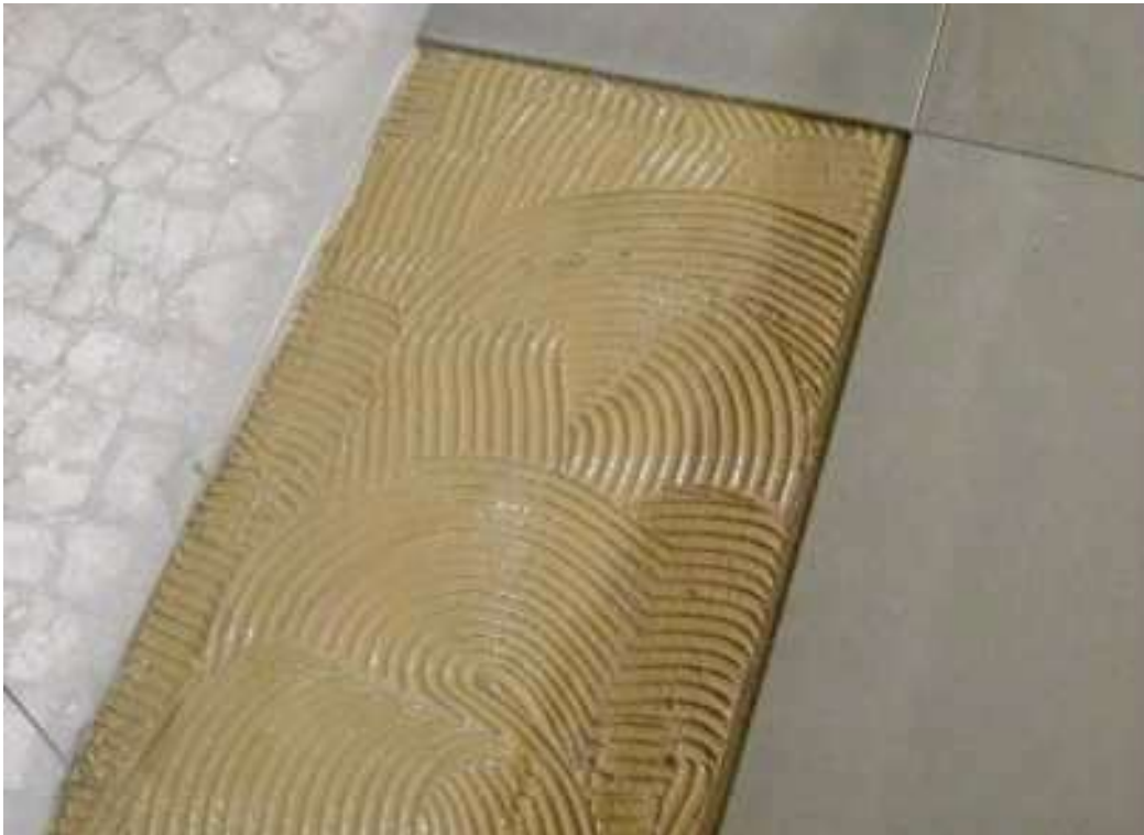
Figura 4.13 – Pavimento Viroc apoiado em suporte contínuo
